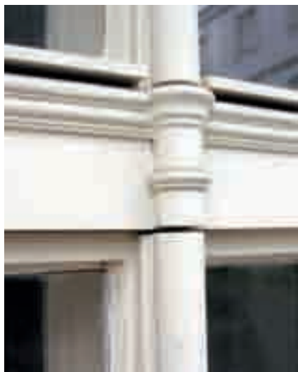
Obr. 14. Klapačka špaletového okna ve tvaru polosloupku je zakončena hlavicí. Poutec je doplněn drobnou profilovanou římsou.
