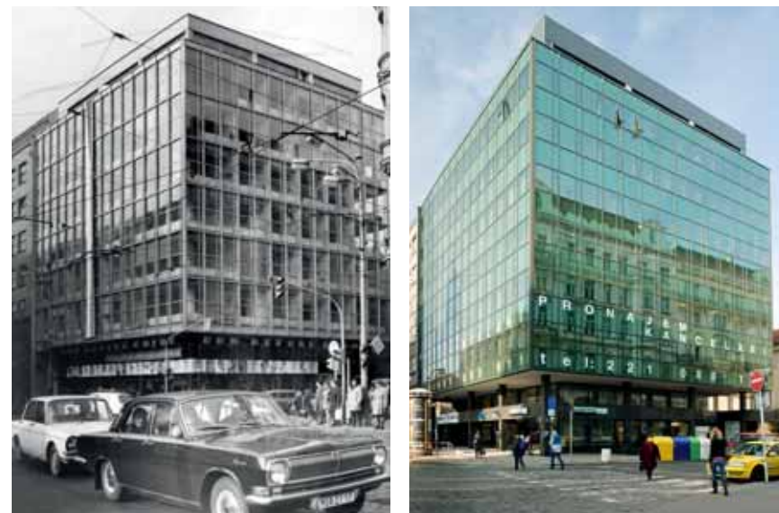
Obr. 1a, b. Praha – Staré Město, Národní třída, dům čp. 342, Dům Albatros. Stanislav Franc – Luděk Hanf – Jan Nováček, 1965–69. Jemně utvářený lehc se vznášející a hravý zavěšený plášť budovy nahradila v 90. letech těžká, tuctově bezduhá stavebnicová soustava. (Foto NPÚ ÚOP v hl. městě Praze, Gabriela Čapková.)
