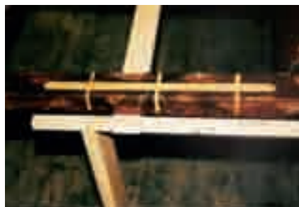
Obr. 31. Detail opravy zkroucené horní části křídla barokního okna. Do vlysu byly na třech místech vyříznuty příčné drážky, následně byl srovnán přitažením k pevné podložce. Do podélné drážky bylo vloženo dřevěné ztužující péro.
