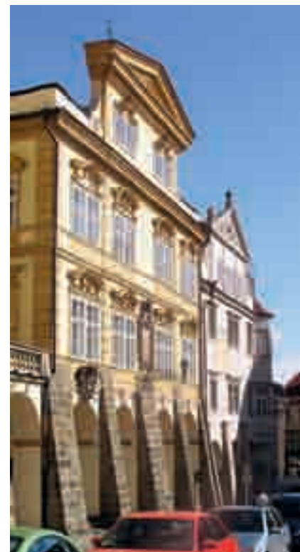
Obr. 15. Praha, Malostranské náměstí, Šternberský palác, čp.7/III. Okna v líci fasády tvoří významnou a ochrany hodnou součást architektonického dědictví. Platí to i pro starší stavby, které měly původně jednoduchá okna ve špaletě.
