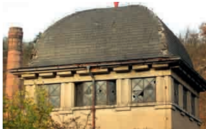
Obr. 19a. V 2. polovině 19. století a v 1. polovině 20. století byla okna průmyslových budov obvykle provedena ze subtilních kovových prutů (takzvaných zasklívacích profilů). Místo běžného pravouhého rastru bylo někdy (spíše však výjimečně) použito diagonální členění.
