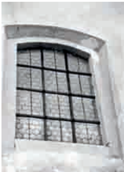
Obr. 18. Chrámové okno členěné vodorovnými a svislými železnými pásy.
