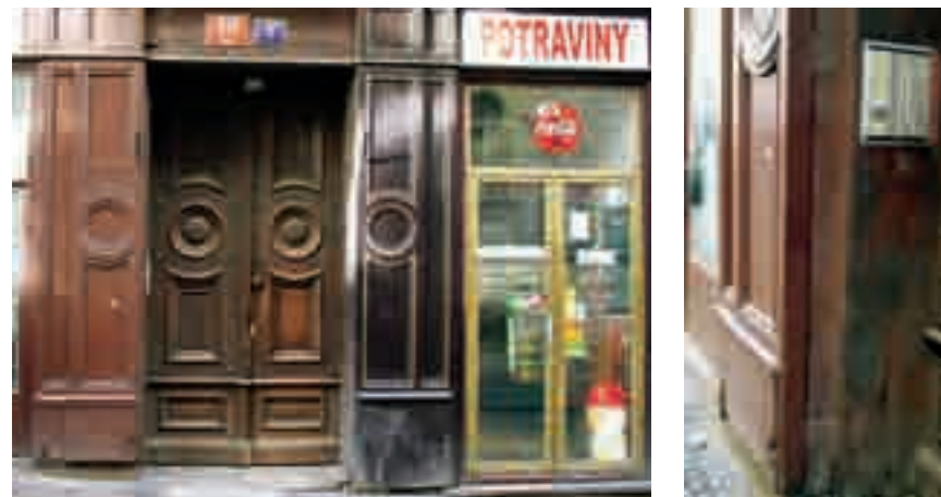
Obr. 10a, b. Praha – Staré Město. Jeden z nejstarších dokladů vznikajících předsazených výkladců z roku 1865. Je současný se stavbou domu, který byl postaven podle plánů J. Schückera. Výkladec již nemá do té doby obvyklá křídla okenic (dveřnic) a nemá ještě rolety, ale má dveřnice skládací do schránek na pilířích. Přes velkou míru zchátralosti a současnou nefunkčnost jsou všechny jeho prvky zachovány. Jde o mimořádně cenný doklad vývoje výkladců.
