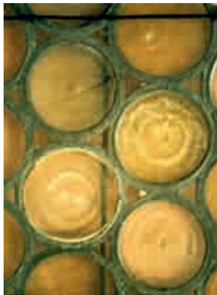
Obr. 7. Terčíky z foukaného skla spojené olověnými lištami. Tabule je na vnitřní straně vyztužena vodorovným železným páskem, na vnější straně svislým železným páskem.
