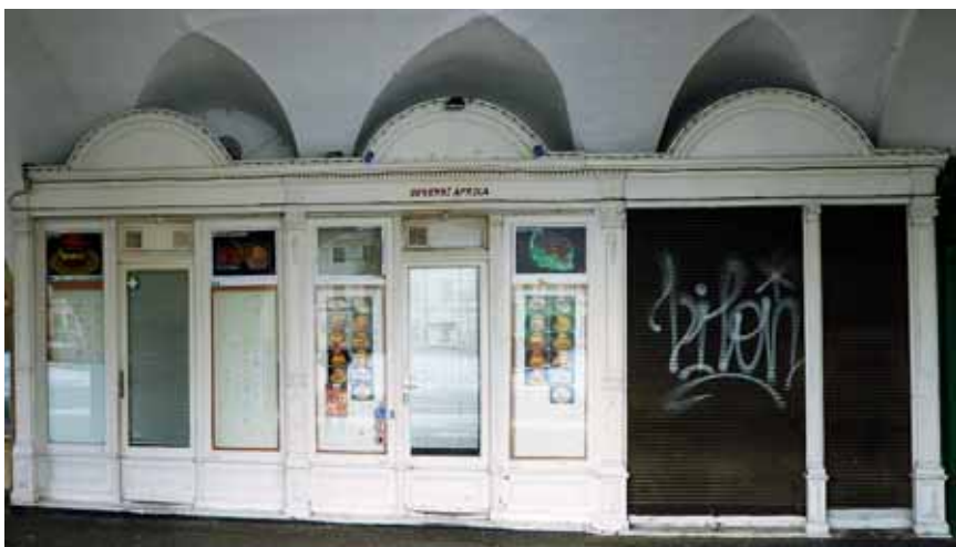
Obr. 12. Hradec Králové. Výkladce s různě upraveným čelem a dekorativními nástavci nebyly původně nijak ojedinělé, zvláště na nárožích a u významnějších obchodů. Dnes jsou zachovány velmi vzácně. Častěji byly používány v podloubí, kde nástavce vyplňovaly prostor mezi výkladcem a klenbou.
