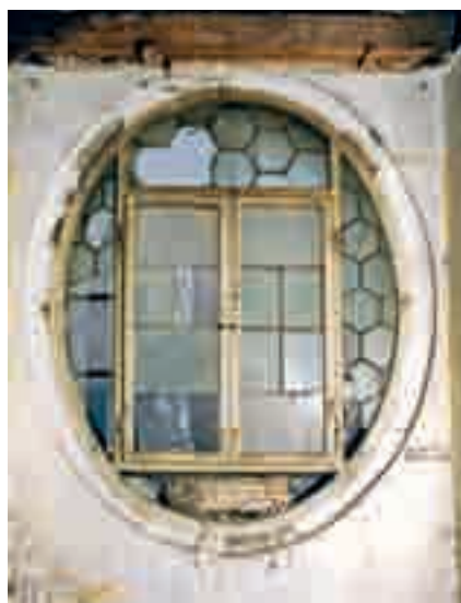
Obr. 8. Do oválného neotvívavého okna zaskleného šestihrany bylo dodatečně vloženo dvoukřídlové okno zasklené obdélnými tabulkami. (Křídla byla při průzkumu nalezena v podkrovní.)
