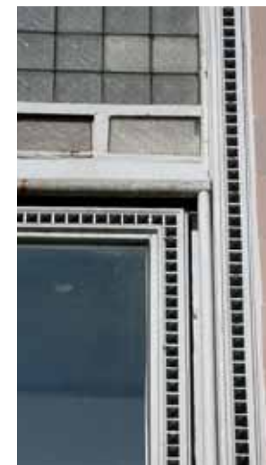
Obr. 18. Jaroměř, Wenkeův obchodní dům, architekt Josef Gočár, 1909–10. Příklad litinových prvků na ocelovém výkladci. (Foto Petr Všeetečka.)
