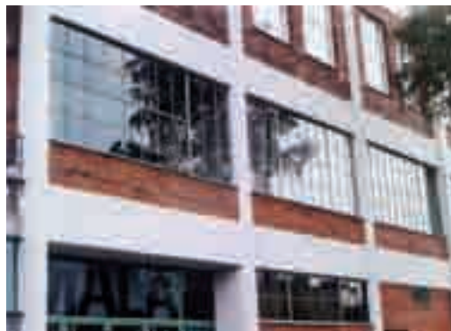
Obr. 10. Společenské a obchodní centrum Díly, architekt Vladimír Karfík, 1936–37, severní průčelí obnovené architektky Jindřichem Škrabalem a Ludvíkem Grymem. Okna s jednoduchým zasklením, s profilací rámu, která neumožňuje vložení dvojskel, jsou neodmyslitelnou součástí industriálních souborů. Repase může být doprovázena zlepšením parametrů jednoduchých skel, v tomto případě tvrdým pokovením.
