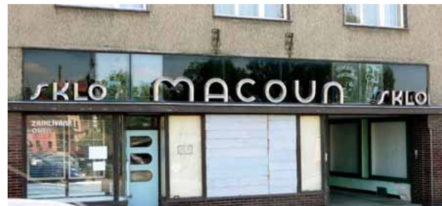
Obr. 36. Turnov. Nápis nad obchody bývaly běžně provedeny technikou podmalby na skle, to znamená, že povrch byl hladký, lesklý a snadno udržovatelný. Dnes je tato technika jen výjimečná. Mezi dvěma válkami dosáhla variabilita firemního označení vrcholu. Hojně byly používány nápisy z jednotlivých kovových písmen, někdy s použitím světelné (neonové) trubice. Tam, kde jsou zachovány, je nutné je chránit. (Foto Martin Halata.)
