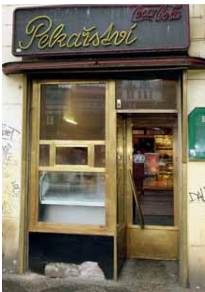
Obr. 21. Praha – Nové Město. Malý funkcionalistický mosazný výkladec, jehož hodnota je i přes zanedbaný stav a nevhodné zásahy zřetelná. Zachovány jsou všechny prvky včetně rolety, svinovací markýzy, obložení parapetu opaxitem, neonové trubice nad výkladcem. Nápisová deska neměla původně oblé rohy a byla těsně na zdi, část prvků je místo očištění nově oplechována.
