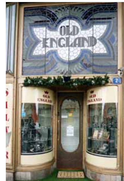
Obr. 23. Hradec Králové. Některé firmy věnovaly své prezentaci mimořádnou pozornost. Na snímku je řešení kovového výkladce s oblymi skly u dveří niky s dekorativně tvarovanými dveřmi a zejména s ojedinělou barevnou vitráží v jejich nadpraží.
