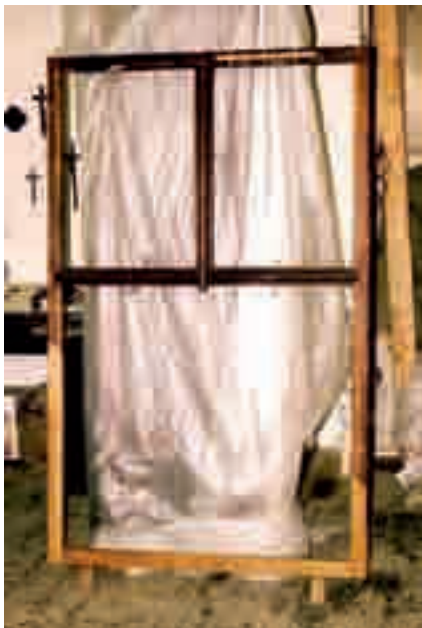
Obr. 29, 30. Ukázka opravy značně poškozeného křídla barokního okna. Byl vyměněn zničený spodní vlys, svislé vlysy byly nastaveny protézami, zkroucený horní vlys byl vyrovnán.
