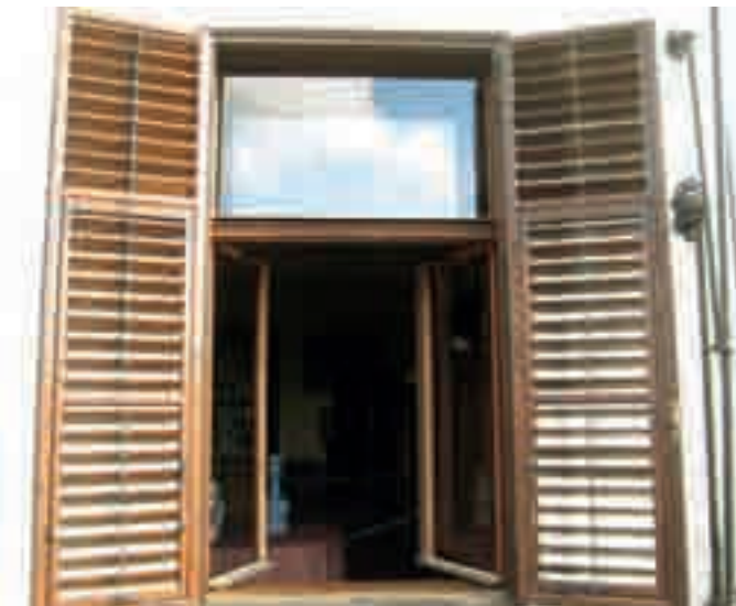
Obr. 32. Více než sto let staré žaluziové okenice mohou po opravě znovu plnit svou funkci.
