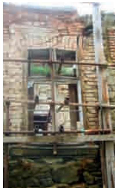
Obr. 2a, b. I značně poškozené okno lze zachránit. Výměna historického okna za kopii by měla být tím nekrajnějším řešením a mělo by se k ní přistupovat jenom v situacích, kdy záchrana a uchování originálu na svém místě nejsou možné. Cenná originální okna by neměla být zničena, nýbrž po stabilizaci a konzervaci umístěna v příslušném studijním depozitáři. (Foto Milan Jančo.)
