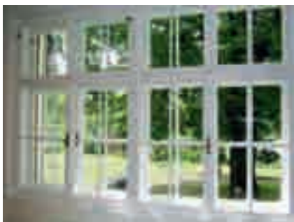
Obr. 12. Dvojité okno působí na rozdíl od jednoduchého prostorovým dojmem zvenku i zevnitř.
