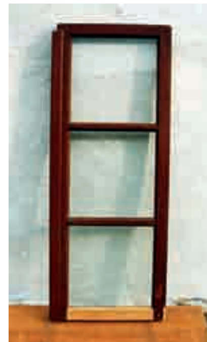
Obr. 28. Po výměně zničeného spodního vlysu křídla může okno dál plnit svou funkci.
