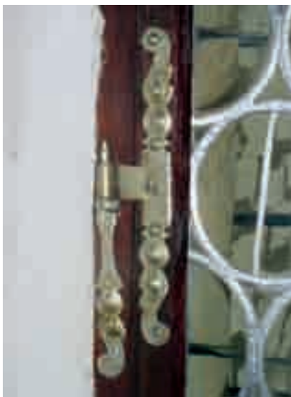
Obr. 6. Zdobený pocínovaný vrchní závěs ve tvaru písmene T. Křídlo barokního okna je zasklené terčíky, které jsou spojeny pocínovanými olověnými lištami. Prasklý terčík je vyspraven olověnou lištou.
