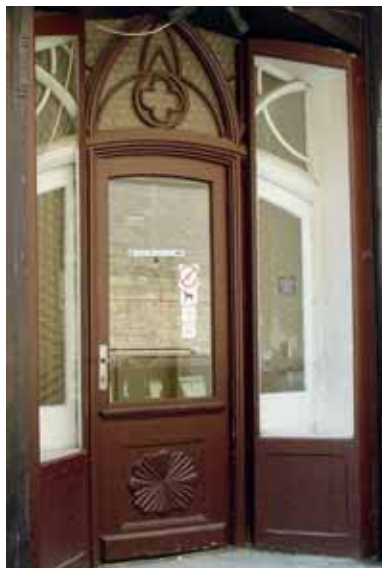
Obr. 16. Louny. Původní dveře jsou často nahrazeny novějšími, protože docházelo k jejich opotřebení a poškození provozem. O to cennějším dokladem jsou výkladce se zachovanými původními dveřmi. Na snímku jsou dekorativně pojednané dveře se shodnými prvky i na vnitřních oknech vitrín, což je ojediněle dochovaný případ.
