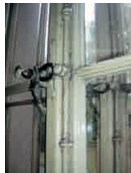
Obr. 11. Detail uzavíracího kování zvaného españoleta. Svislá otočná tyčka je ovládána klíčkou.
