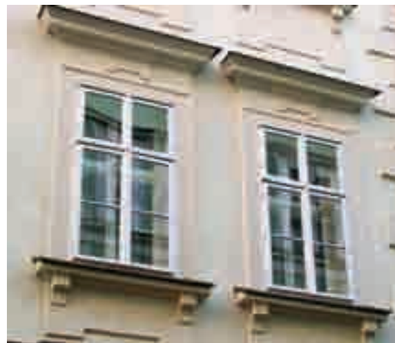
Obr. 17. Praha – Malá Strana, dům čp. 20/III. Výměna vnějších oken umožnila zachovat na místě památkově hodnotnější okna vnitřní. V nových dřevěných venotvíracích křídlech vnějších oken je osazeno dvojsklo. Výsledek úpravy lze považovat za zdařilý.
