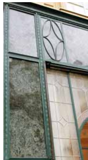
Obr. 17. Praha – Staré Město. Ocelový výkladec s aplikovanými litinovými pásky s plastickým vegetabilním dekorem.
