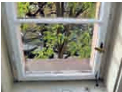
Obr. 13, 14. Zdánlivé maličkosti: při srovnání původního okna a jeho rádooby kopie si všimneme, že historické kování je nahrazeno typizovaným současným výrobkem. Liší se profilace rámu. U nového okna je profilovaná dělicí přičle nahrazena nalepením čehosi na sklo... Poučení je dvojit. Preferovat zachování originálu před výměnou, byť by to mělo být za „kopii“. Pokud již není reálné jiné řešení než výměna, věnovat pozornost detailům.
