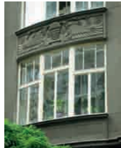
Obr. 16. V 1. polovině 20. století byla vrchní nebo spodní část oken poměrně často dělena na menší tabulky. Méně obvyklé bylo používání diagonálních příčí.
