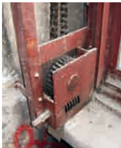
Obr. 20b. Výsuvná horní křídla rozměrných kovových oken byla zvedána řetězovým mechanismem ovládaným klikou.
