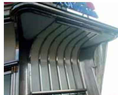
Obr. 22. Praha – Libeň. Významnější výkladce ze 30. let 20. století vynikají nejen svou architektonickou kvalitou, ale i naprosto mimořádnou řemeslnou dokonalostí. Na snímku výkladec podle návrhu Maxe Gerstla (podle Z. Lukeše) na starším domě. Technické detaily jsou perfektně zpracovány, táhla (vzpěry markýz) jsou zapuštěna tak, že je téměř nelze rozeznat. Chromovaný povrch kovové konstrukce doplňuje travertinové obložení a průběžná fabionová římsa s mléčným sklem, nad nárožním vstupem přecházející do zaoblené markýzy.
