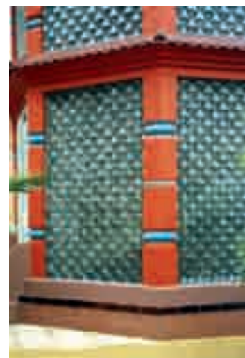
Obr. 21a. Lázně Luhačovice, vila Jestřabí, architekt D. Jurkovič. Okno z baňkovitých skleněných tvárníc je působivou součástí budovy z počátku 20. století.
