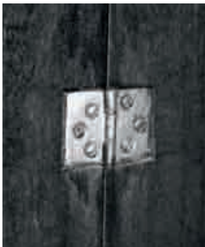
Obr. 2. Kloubový závěs skládací okenice.
