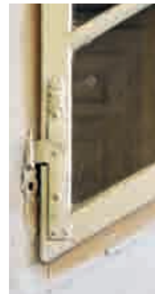
Obr. 1b. Starší rohovníkový závěs přizpůsobený pro druhotné použití na kosodélníkovém schodišťovém okně.
